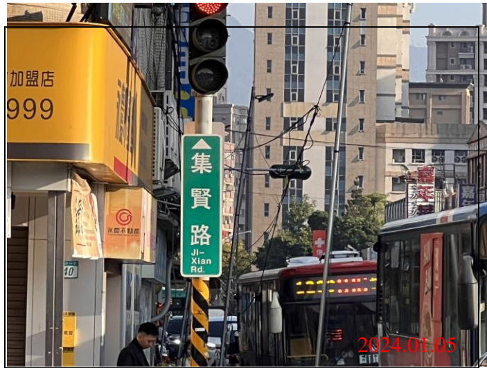
巡查日期地點：113.01.05/ Y21車站 照片說明：牌面設置狀況
