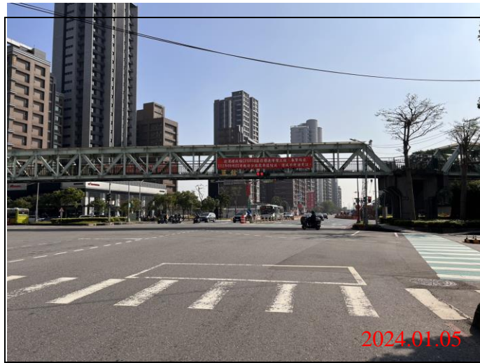
巡查日期地點：113.01.05/ Y23車站 照片說明：路面狀況
