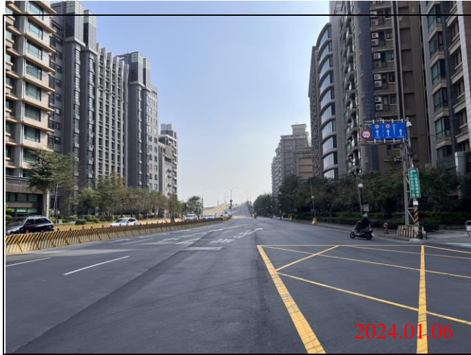
巡查日期地點：113.01.06/ Y23車站 照片說明：路面狀況
