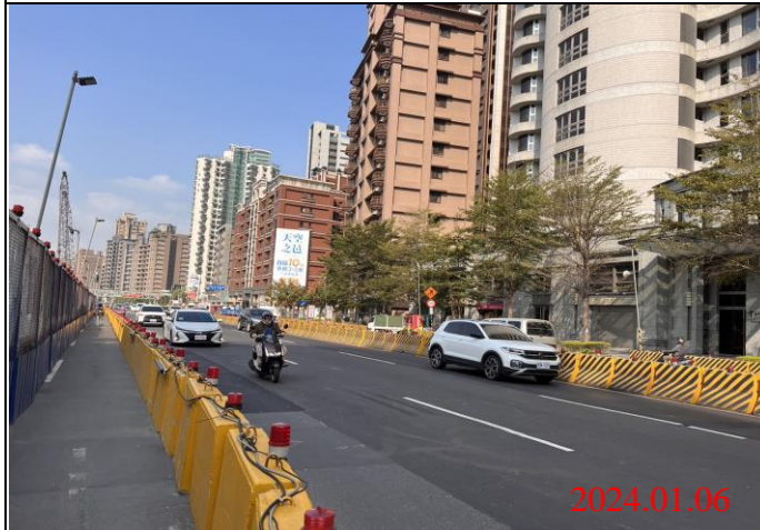
巡查日期地點：113.01.06/ Y23車站 照片說明：路面狀況
