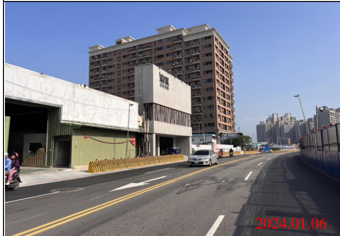
巡查日期地點：113.01.06/ Y22車站 照片說明：路面狀況
