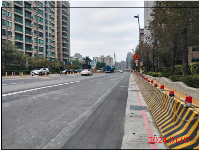
巡查日期地點：113.01.07/ Y23車站 照片說明：路面狀況
