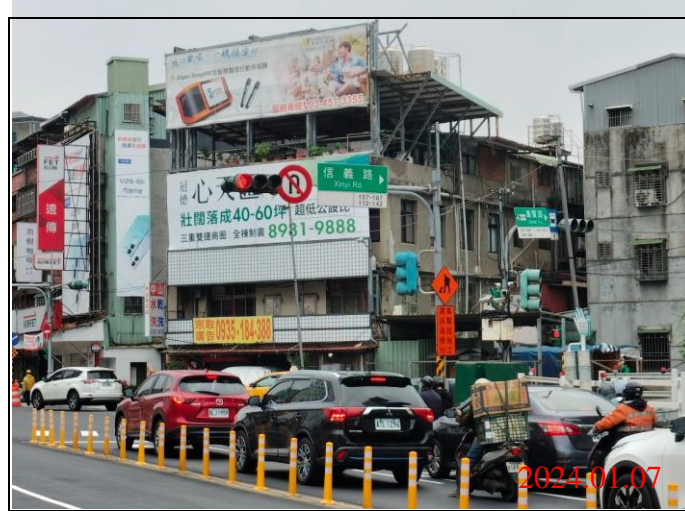
巡查日期地點：113.01.07/ Y21車站 照片說明：牌面設置狀況
