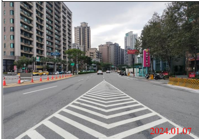
巡查日期地點：113.01.07/ Y22車站 照片說明：路面狀況
