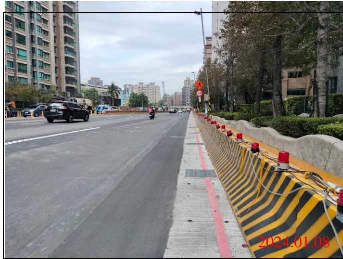
巡查日期地點：113.01.08/ Y23車站 照片說明：路面狀況
