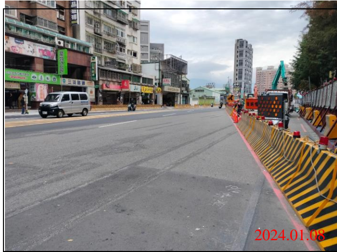
巡查日期地點：113.01.08/ Y22車站 照片說明：路面狀況
