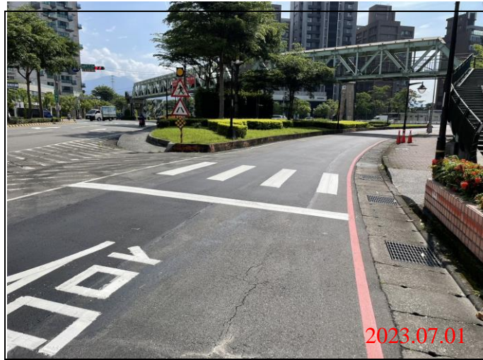
巡查日期地點：112.07.01/ Y23車站 照片說明：路面狀況
