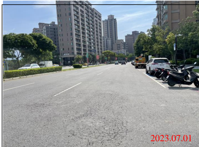
巡查日期地點：112.07.01/ Y22車站 照片說明：路面狀況
