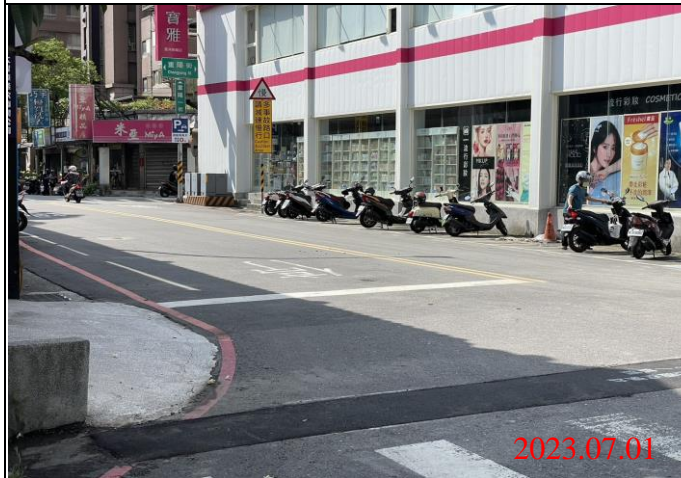
巡查日期地點：112.07.01/ Y21車站 照片說明：路面狀況
