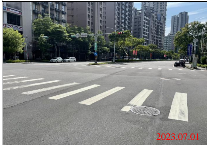
巡查日期地點：112.07.01/ Y22車站 照片說明：路面狀況
