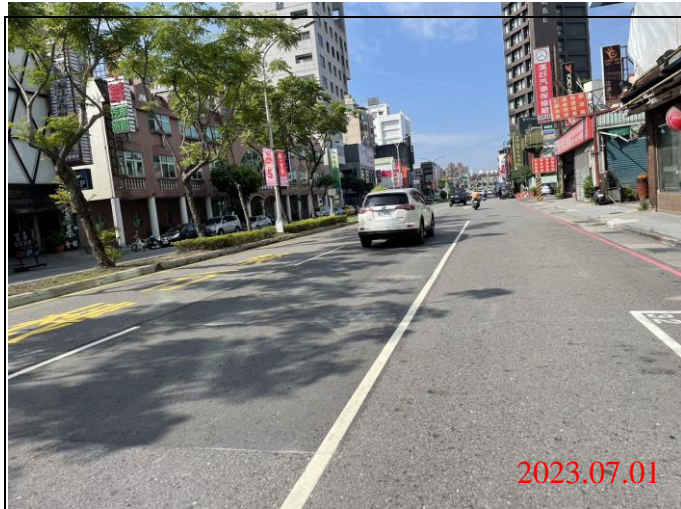
巡查日期地點：112.07.01/ Y21車站 照片說明：路面狀況
