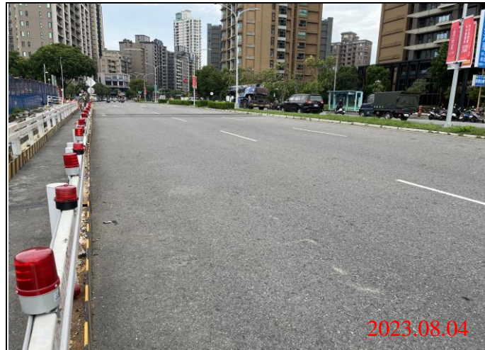
巡查日期地點：112.08.04/ Y22車站 照片說明：路面狀況
