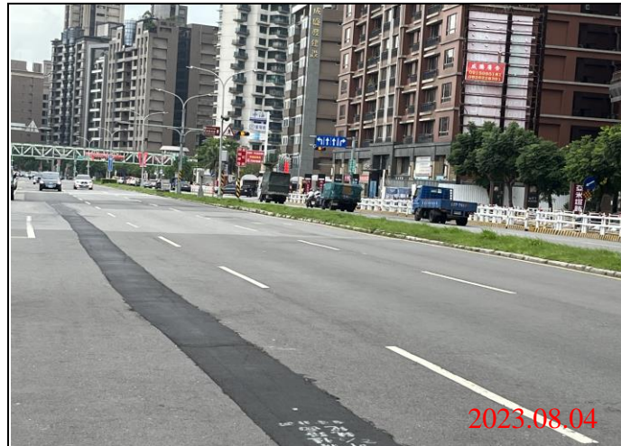
巡查日期地點：112.08.04/ Y23車站 照片說明：路面狀況
