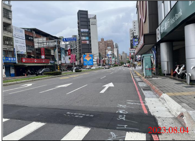
巡查日期地點：112.08.04/ Y21車站 照片說明：路面狀況
