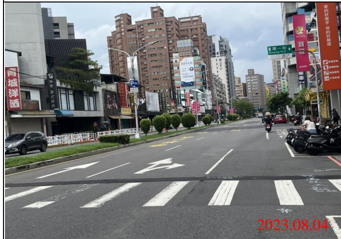
巡查日期地點：112.08.04/ Y21車站 照片說明：路面狀況
