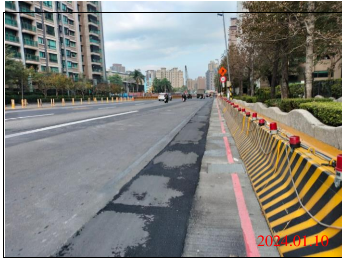
巡查日期地點：113.01.10/ Y23車站 照片說明：路面狀況
