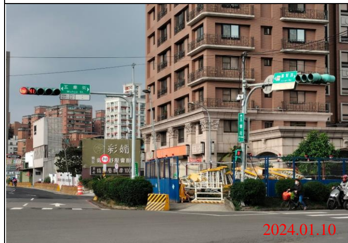
巡查日期地點：113.01.10/ Y22車站 照片說明：牌面設置狀況
