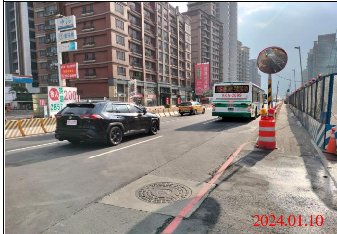
巡查日期地點：113.01.10/ Y23車站 照片說明：路面狀況
