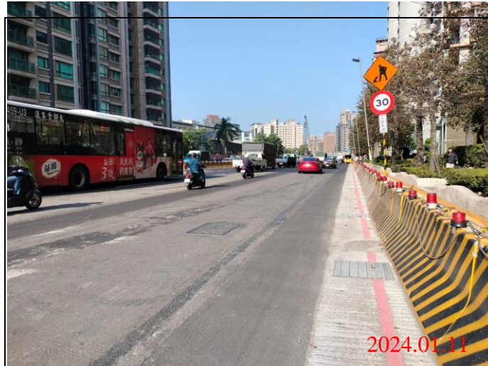
巡查日期地點：113.01.11/ Y23車站 照片說明：路面狀況
