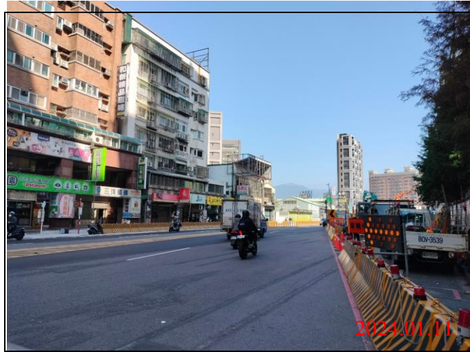
巡查日期地點：113.01.11/ Y22車站 照片說明：路面狀況
