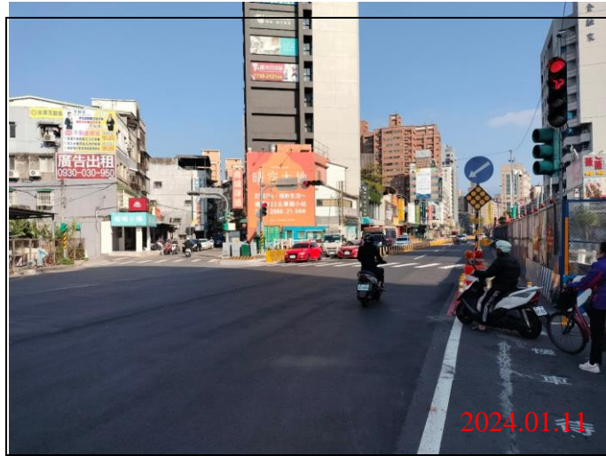
巡查日期地點：113.01.11/ Y21車站 照片說明：路面狀況
