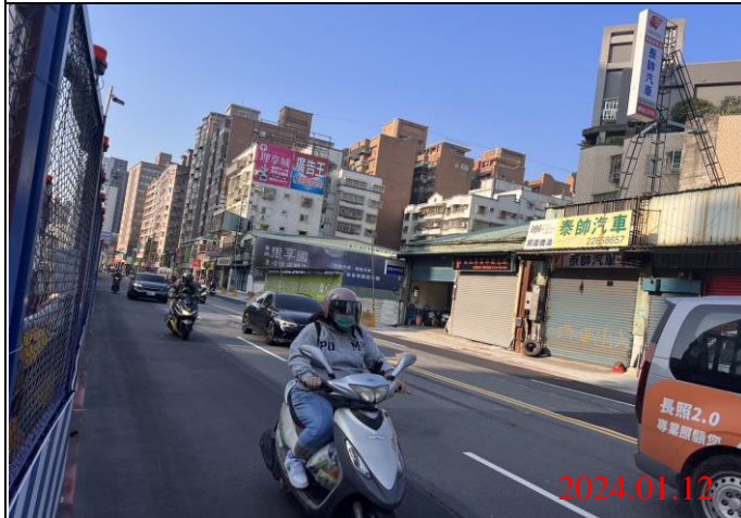
巡查日期地點：113.01.12/ Y22車站 照片說明：路面狀況
