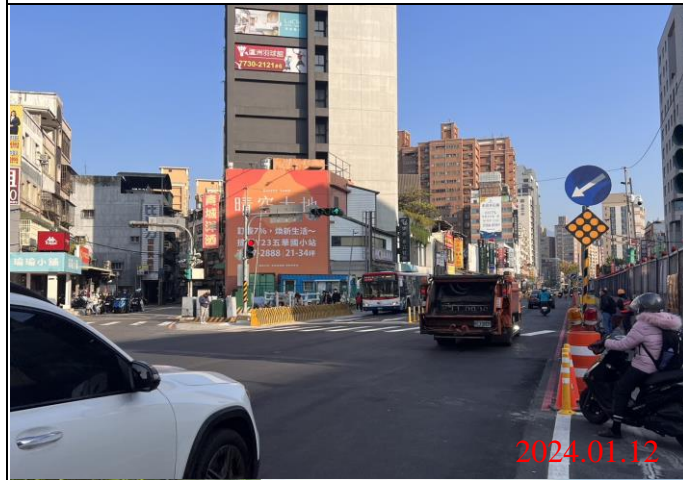
巡查日期地點：113.01.12/ Y21車站 照片說明：路面狀況
