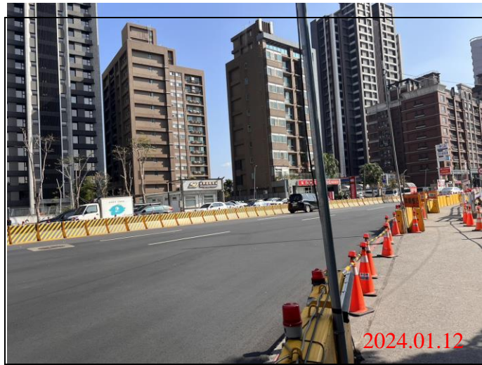
巡查日期地點：113.01.12/ Y23車站 照片說明：路面狀況
