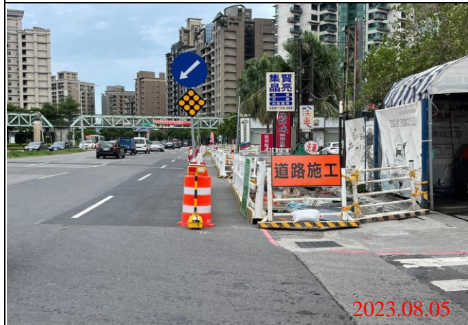
巡查日期地點：112.08.05/ Y23車站 照片說明：牌面設置狀況
