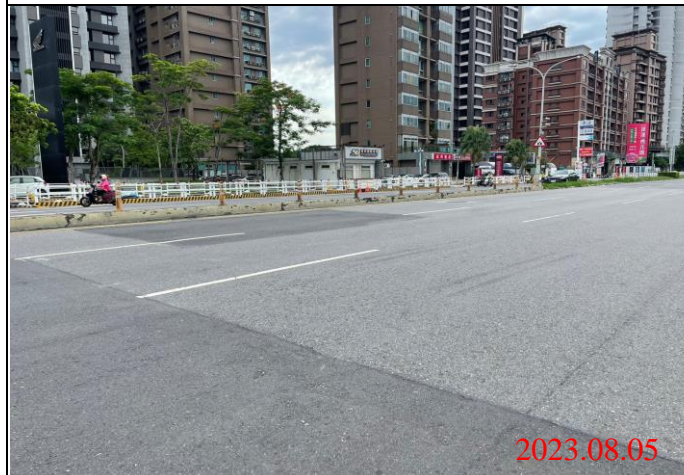
巡查日期地點：112.08.05/ Y23車站 照片說明：路面狀況
