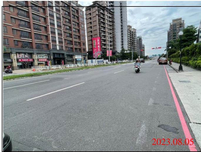
巡查日期地點：112.08.05/ Y23車站 照片說明：路面狀況
