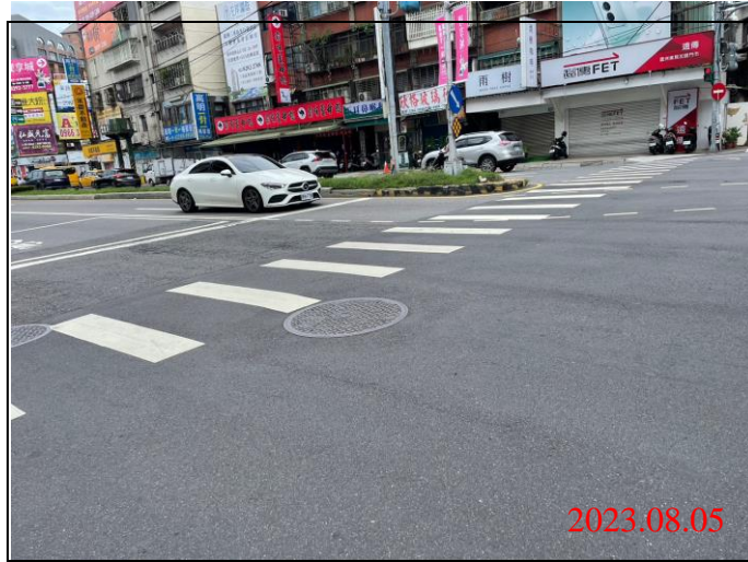
巡查日期地點：112.08.05/ Y21車站 照片說明：路面狀況
