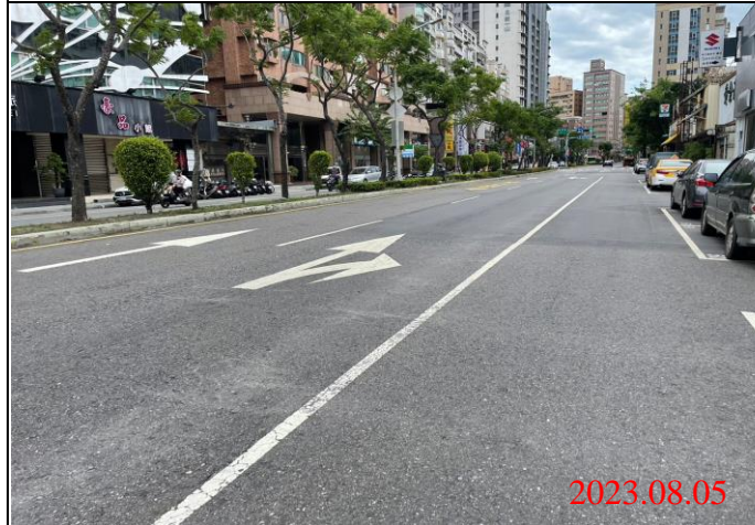
巡查日期地點：112.08.05/ Y21車站 照片說明：路面狀況
