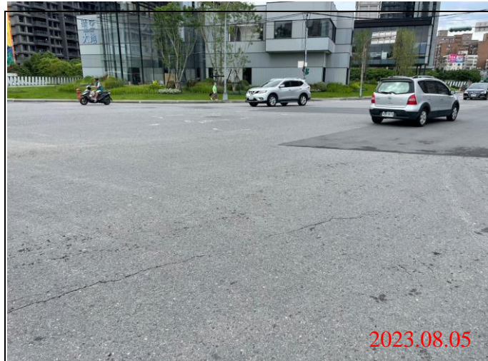
巡查日期地點：112.08.05/ Y22車站 照片說明：路面狀況
