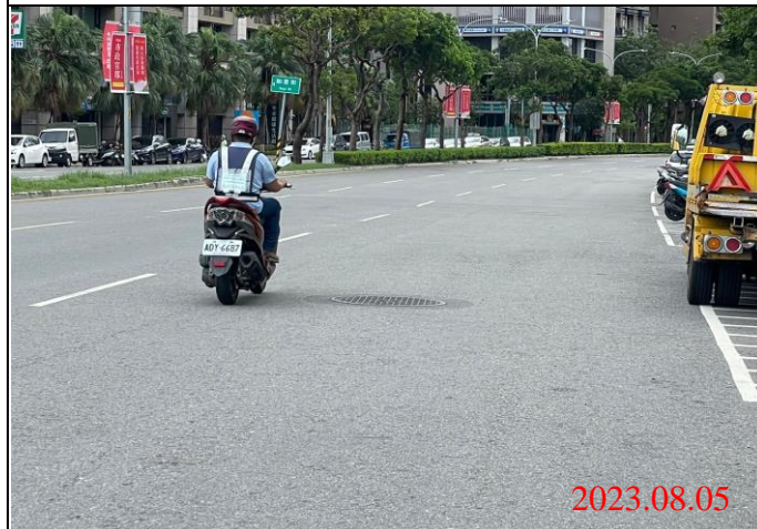
巡查日期地點：112.08.05/ Y22車站 照片說明：路面狀況
