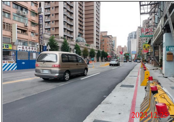
巡查日期地點：112.12.25/ Y22車站 照片說明：路面狀況
