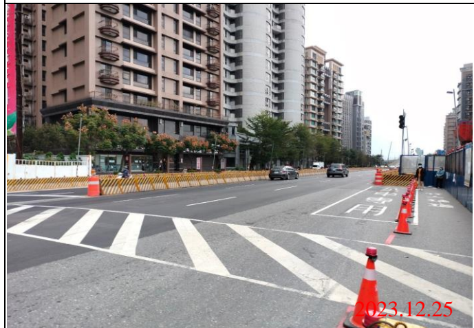
巡查日期地點：112.12.25/ Y23車站 照片說明：路面狀況
