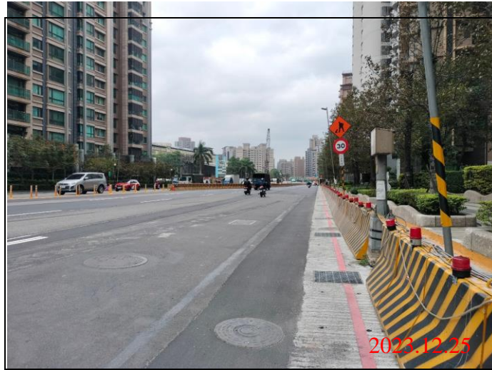
巡查日期地點：112.12.25/ Y23車站 照片說明：路面狀況
