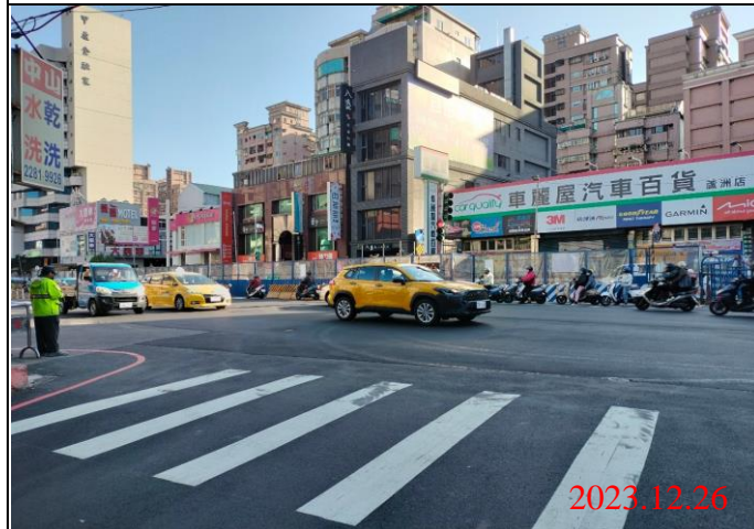
巡查日期地點：112.12.26/ Y21車站 照片說明：路面狀況
