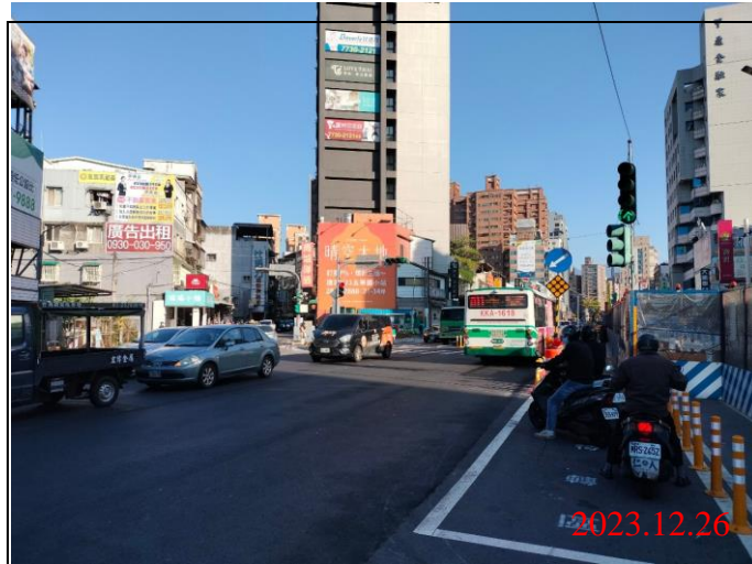
巡查日期地點：112.12.26/ Y21車站 照片說明：路面狀況
