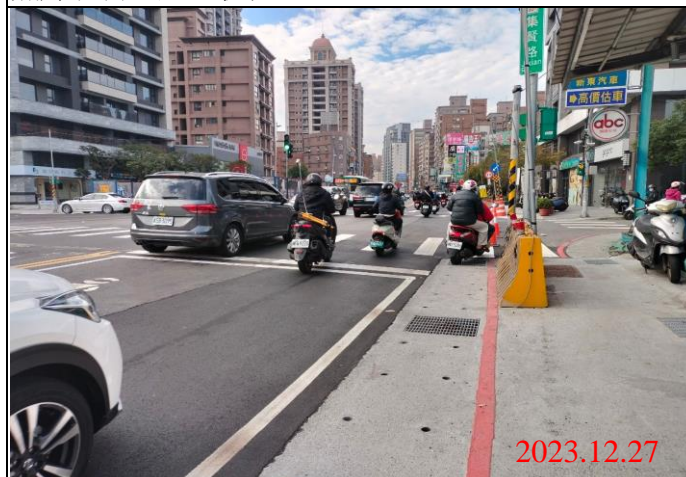
巡查日期地點：112.12.27/ Y22車站 照片說明：路面狀況
