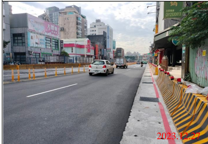
巡查日期地點：112.12.27/ Y21車站 照片說明：路面狀況
