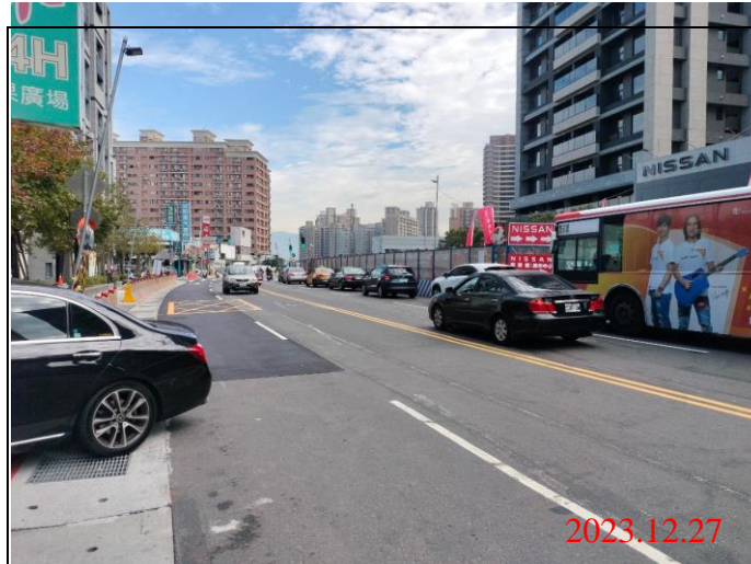
巡查日期地點：112.12.27/ Y22車站 照片說明：路面狀況
