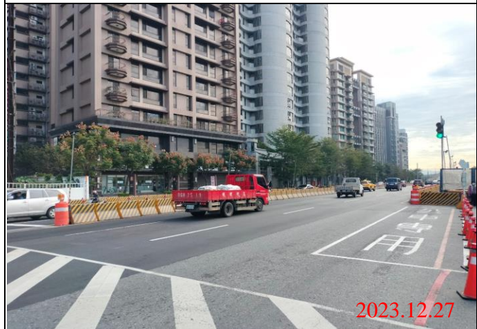
巡查日期地點：112.12.27/ Y23車站 照片說明：路面狀況
