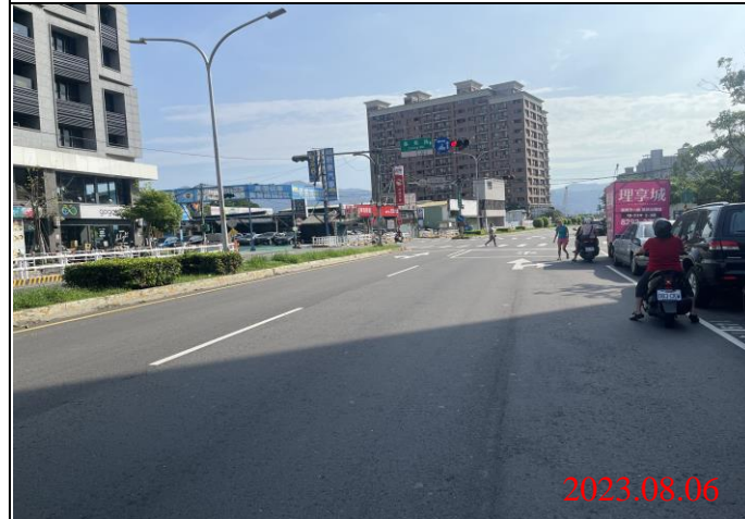
巡查日期地點：112.08.06/ Y22車站 照片說明：路面狀況
