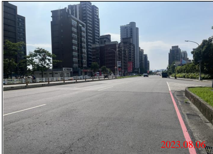
巡查日期地點：112.08.06/ Y23車站 照片說明：路面狀況
