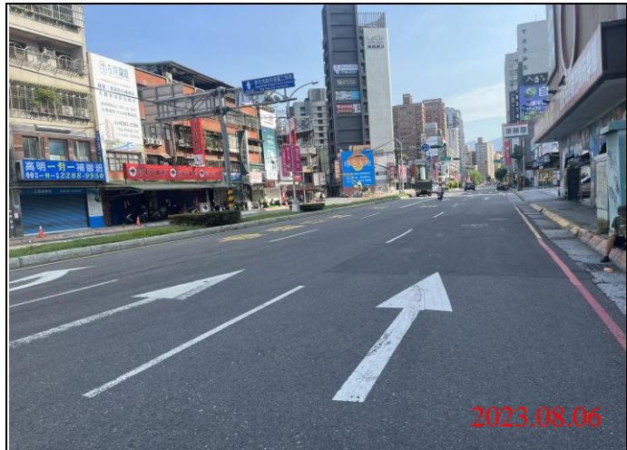
巡查日期地點：112.08.06/ Y21車站 照片說明：路面狀況
