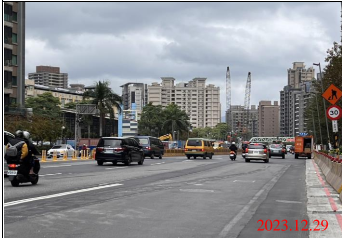
巡查日期地點：112.12.29/ Y23車站 照片說明：路面狀況
