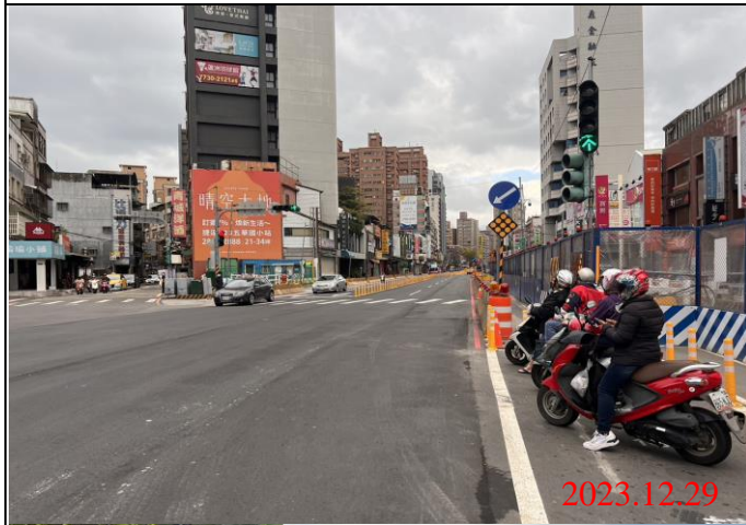
巡查日期地點：112.12.29/ Y21車站 照片說明：路面狀況
