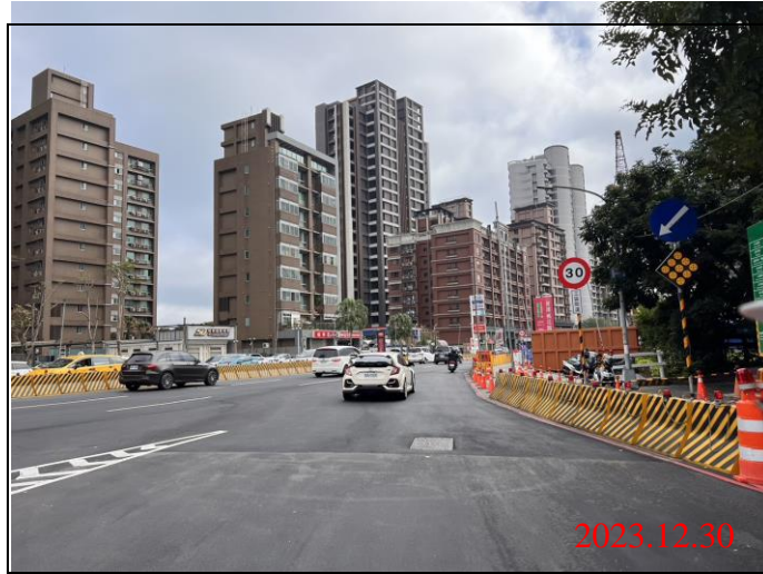
巡查日期地點：112.12.30/ Y23車站 照片說明：路面狀況
