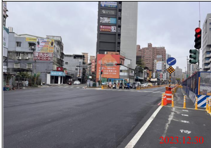
巡查日期地點：112.12.30/ Y21車站 照片說明：路面狀況
