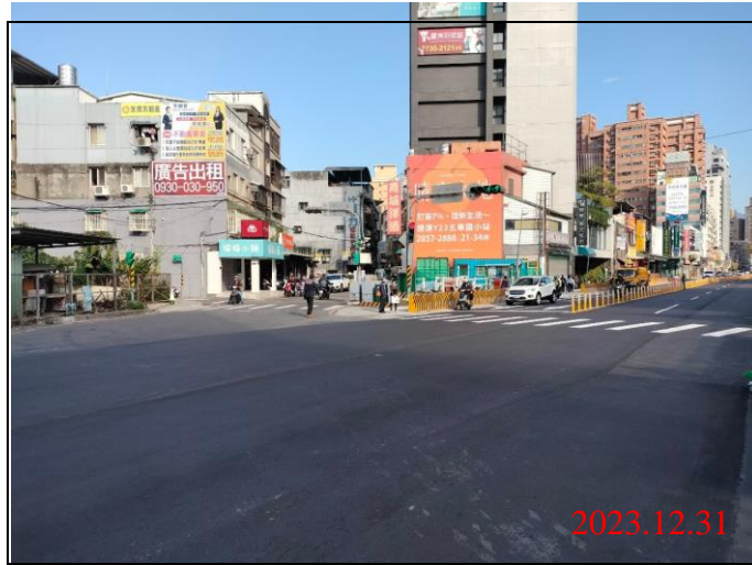
巡查日期地點：112.12.31/ Y21車站 照片說明：路面狀況
