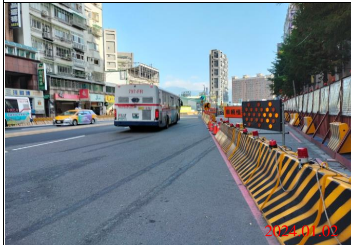
巡查日期地點：113.01.02/ Y22車站 照片說明：路面狀況
