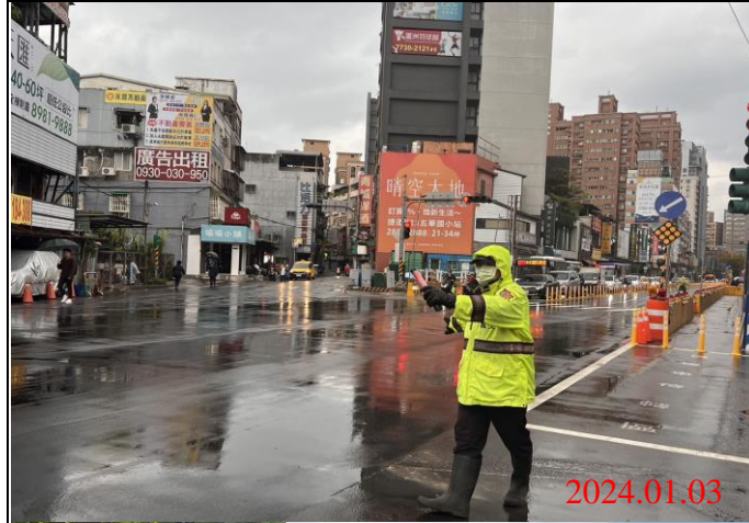
巡查日期地點：113.01.03/ Y21車站 照片說明：路面狀況
