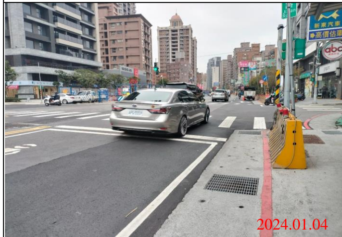
巡查日期地點：113.01.04/ Y22車站 照片說明：路面狀況
