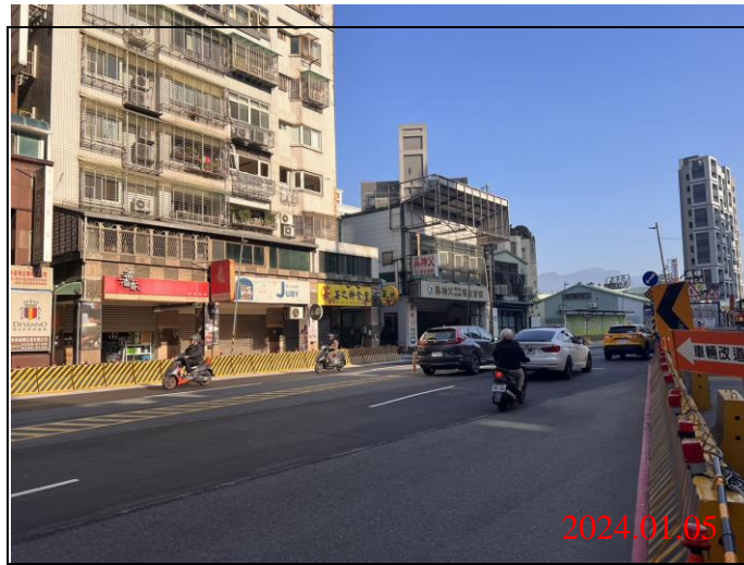
巡查日期地點：113.01.05/ Y22車站 照片說明：路面狀況
