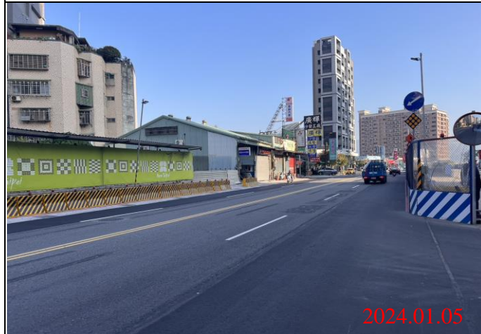
巡查日期地點：113.01.05/ Y22車站 照片說明：路面狀況
