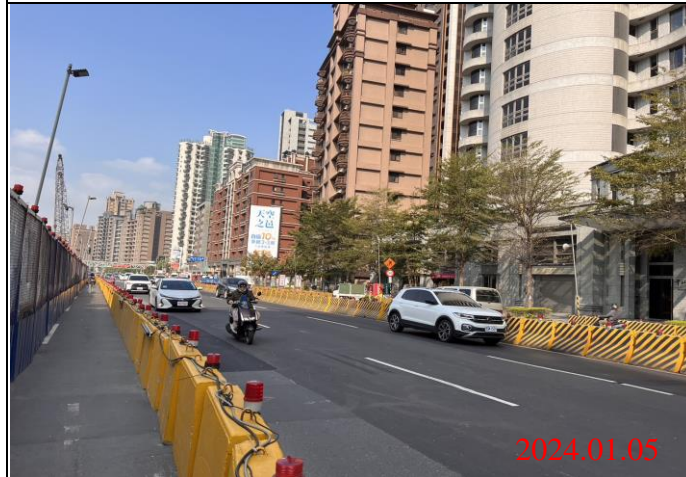
巡查日期地點：113.01.05/ Y23車站 照片說明：路面狀況
