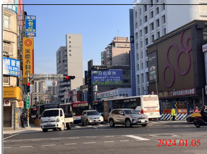
巡查日期地點：113.01.05/ Y21車站 照片說明：路面狀況
