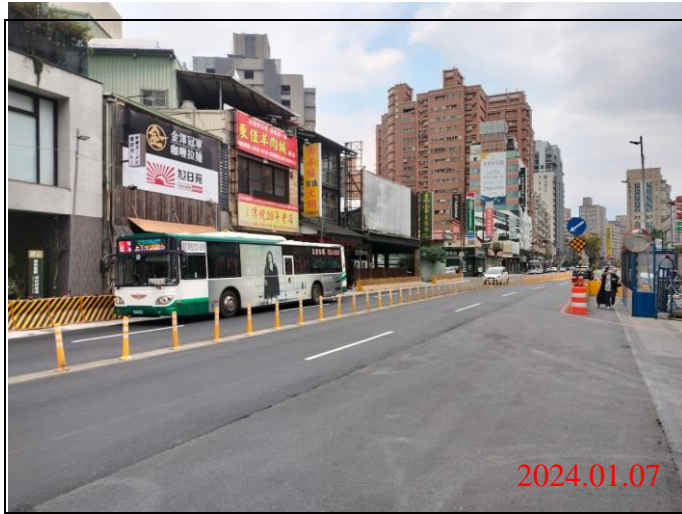
巡查日期地點：113.01.07/ Y21車站 照片說明：路面狀況
