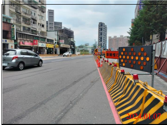
巡查日期地點：113.01.07/ Y22車站 照片說明：路面狀況
