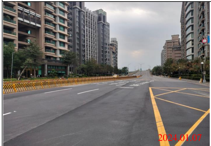
巡查日期地點：113.01.07/ Y23車站 照片說明：路面狀況
