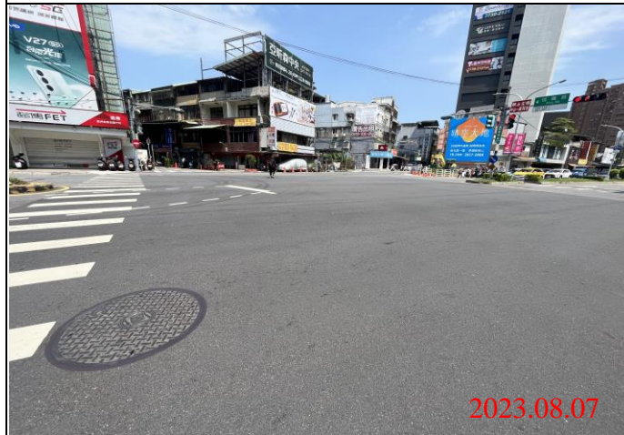
巡查日期地點：112.08.07/ Y21車站 照片說明：路面狀況
