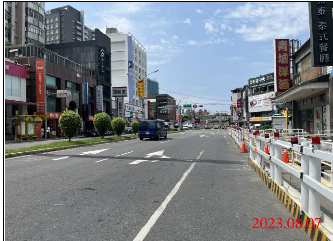
巡查日期地點：112.08.07/ Y21車站 照片說明：路面狀況
