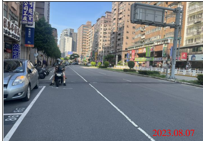
巡查日期地點：112.08.07/ Y22車站 照片說明：路面狀況
