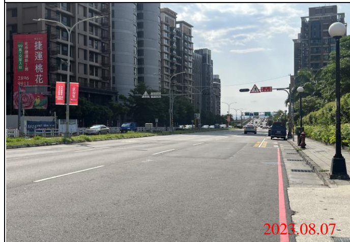
巡查日期地點：112.08.07/ Y23車站 照片說明：路面狀況
