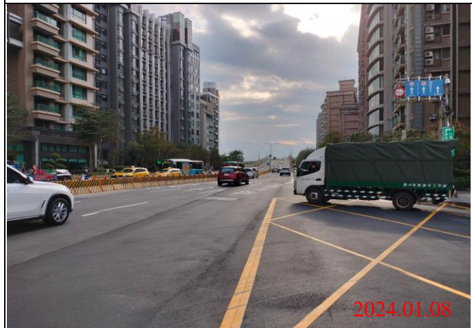
巡查日期地點：113.01.08/ Y23車站 照片說明：路面狀況
