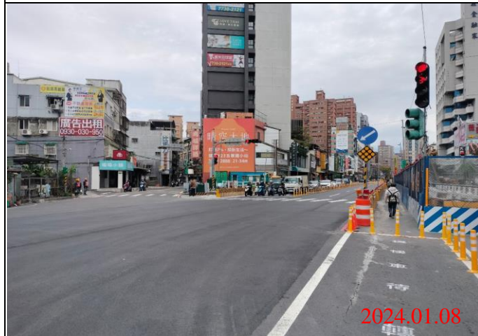
巡查日期地點：113.01.08/ Y21車站 照片說明：路面狀況
