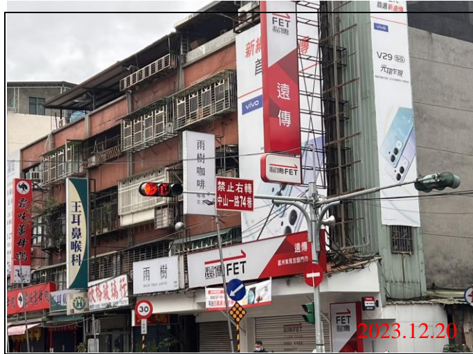
巡查日期地點：112.12.20/ Y21車站 照片說明：牌面設置狀況
