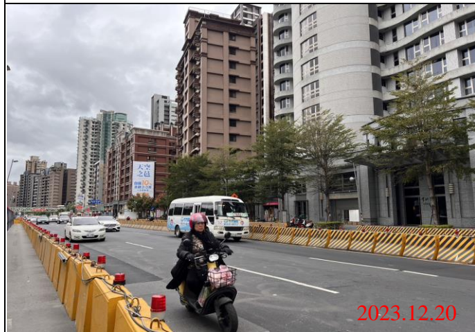
巡查日期地點：112.12.20/ Y23車站 照片說明：路面狀況
