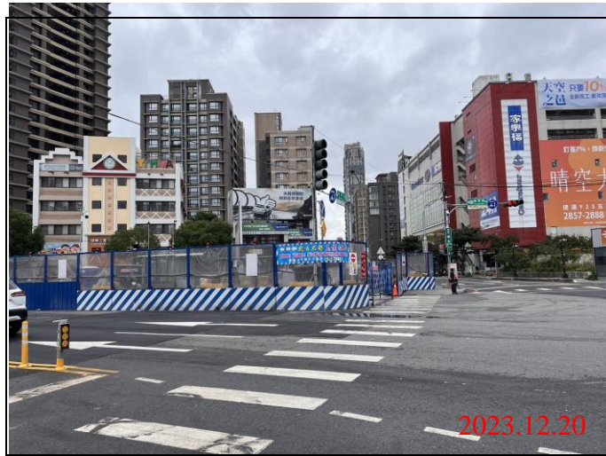
巡查日期地點：112.12.20/ Y22車站 照片說明：路面狀況
