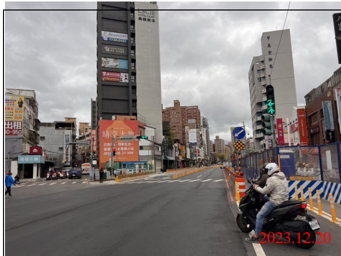
巡查日期地點：112.12.20/ Y21車站 照片說明：路面狀況
