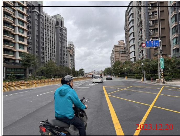
巡查日期地點：112.12.20/ Y23車站 照片說明：路面狀況
