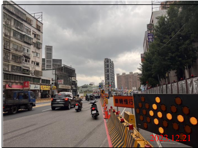
巡查日期地點：112.12.21/ Y22車站 照片說明：路面狀況
