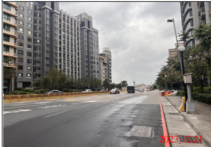
巡查日期地點：112.12.21/ Y23車站 照片說明：路面狀況
