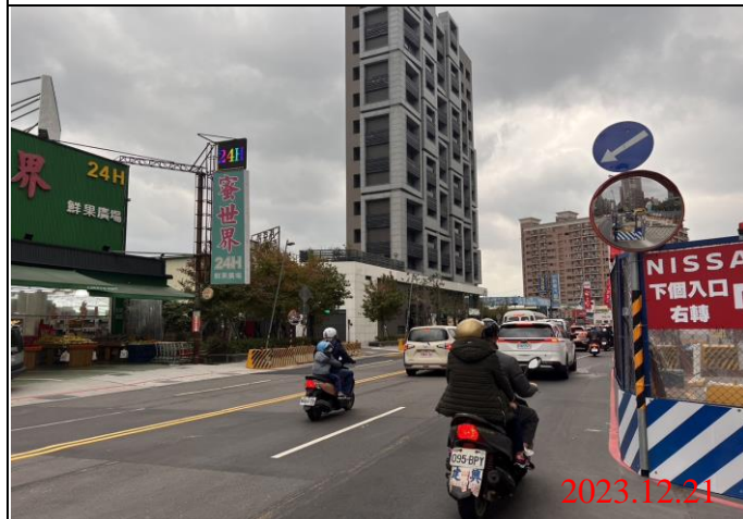
巡查日期地點：112.12.21/ Y22車站 照片說明：路面狀況
