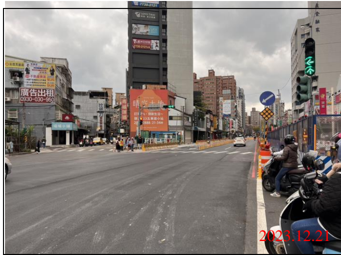
巡查日期地點：112.12.21/ Y21車站 照片說明：路面狀況
