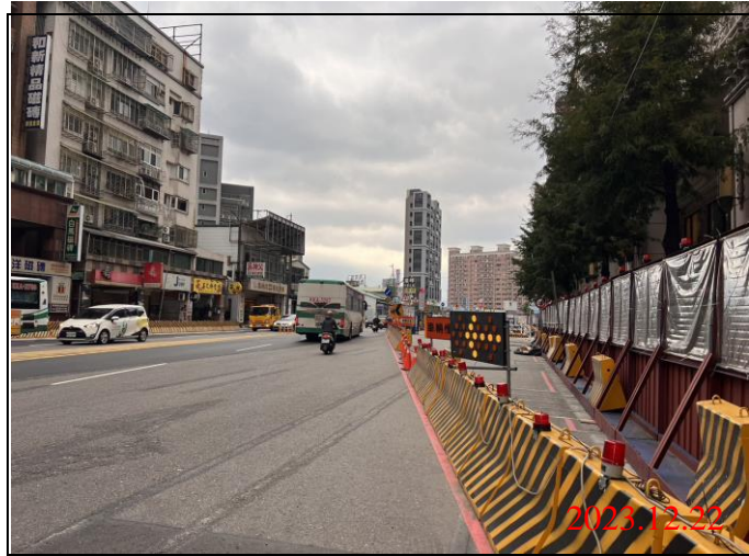
巡查日期地點：112.12.22/ Y22車站 照片說明：路面狀況
