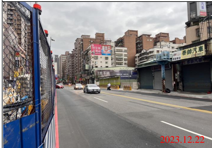
巡查日期地點：112.12.22/ Y22車站 照片說明：路面狀況
