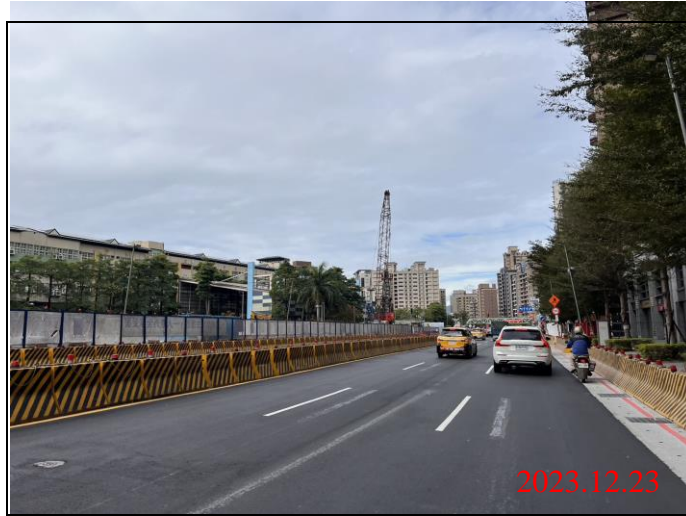
巡查日期地點：112.12.23/ Y23車站 照片說明：路面狀況
