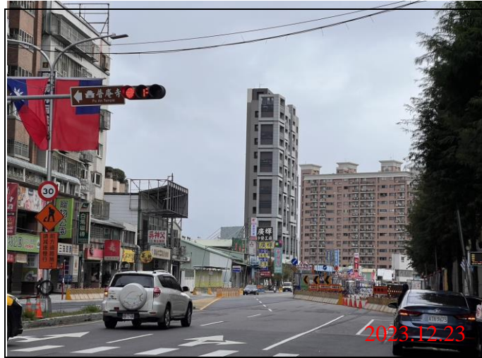
巡查日期地點：112.12.23/ Y22車站 照片說明：路面狀況
