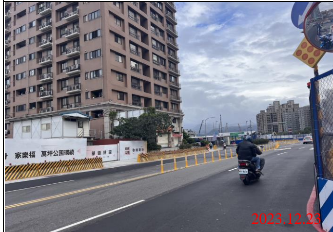
巡查日期地點：112.12.23/ Y22車站 照片說明：路面狀況
