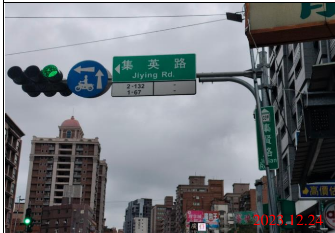
巡查日期地點：112.12.24/ Y22車站 照片說明：牌面設置狀況
