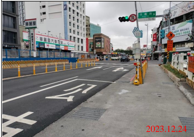
巡查日期地點：112.12.24/ Y21車站 照片說明：路面狀況
