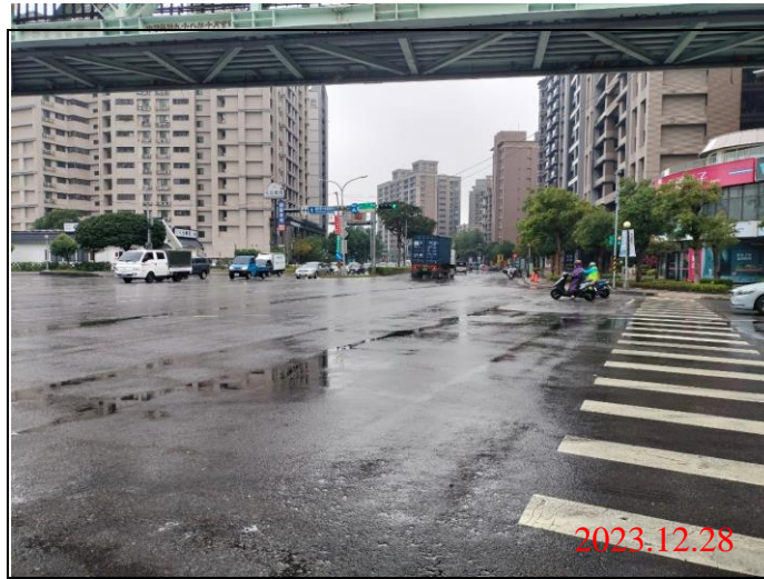
巡查日期地點：112.12.28/ Y23車站 照片說明：路面狀況
