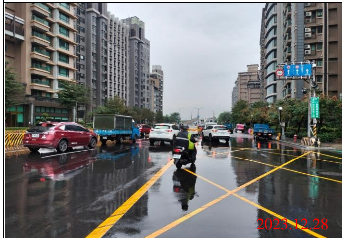
巡查日期地點：112.12.28/ Y23車站 照片說明：路面狀況
