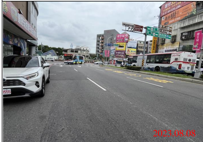
巡查日期地點：112.08.08/ Y21車站 照片說明：路面狀況
