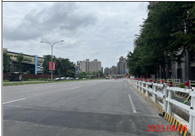
巡查日期地點：112.08.08/ Y23車站 照片說明：路面狀況
