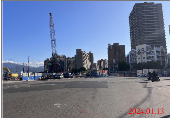
巡查日期地點：113.01.13/ Y22車站 照片說明：路面狀況
