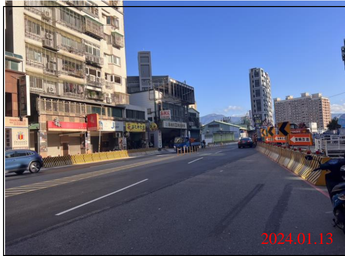
巡查日期地點：113.01.13/ Y22車站 照片說明：路面狀況
