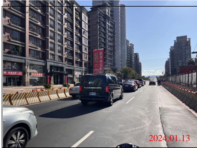
巡查日期地點：113.01.13/ Y23車站 照片說明：路面狀況
