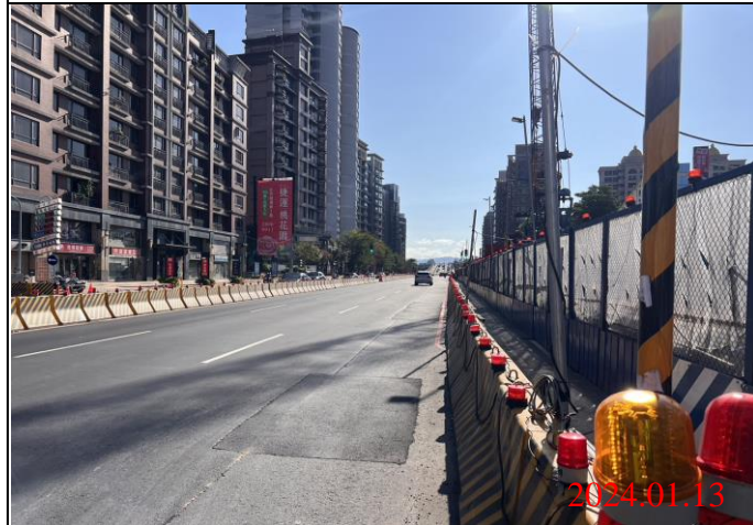
巡查日期地點：113.01.13/ Y23車站 照片說明：路面狀況
