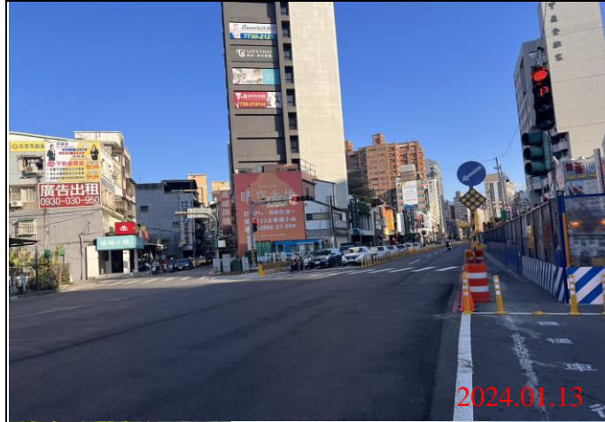
巡查日期地點：113.01.13/ Y21車站 照片說明：路面狀況
