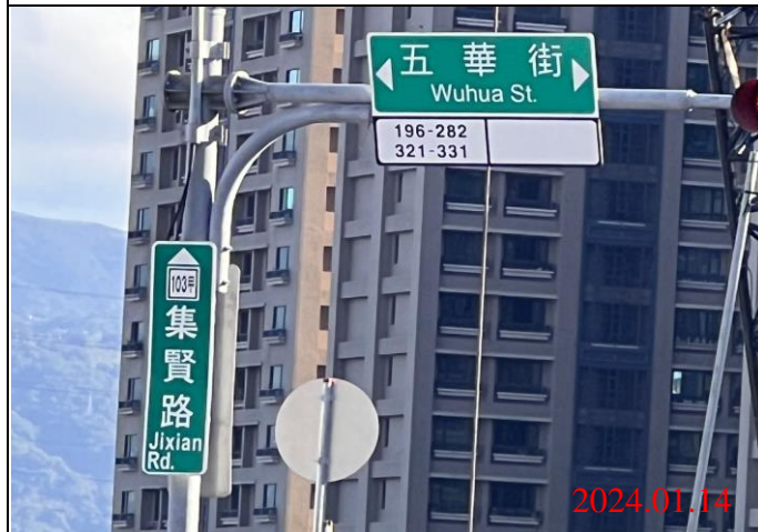
巡查日期地點：113.01.14/ Y22車站 照片說明：牌面設置狀況
