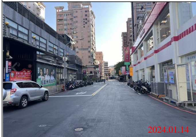
巡查日期地點：113.01.14/ Y21車站 照片說明：路面狀況
