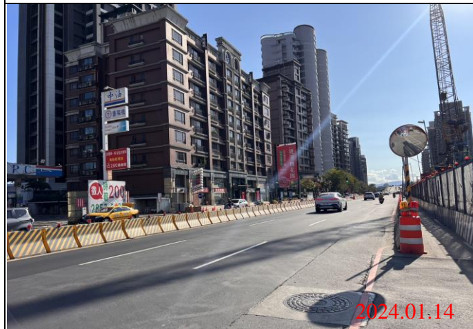
巡查日期地點：113.01.14/ Y23車站 照片說明：路面狀況
