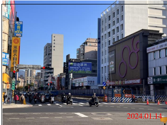
巡查日期地點：113.01.14/ Y21車站 照片說明：路面狀況
