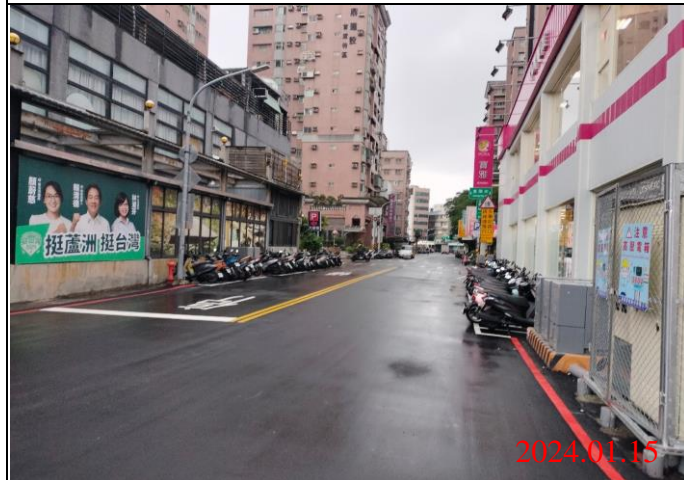
巡查日期地點：113.01.15/ Y21車站 照片說明：路面狀況
