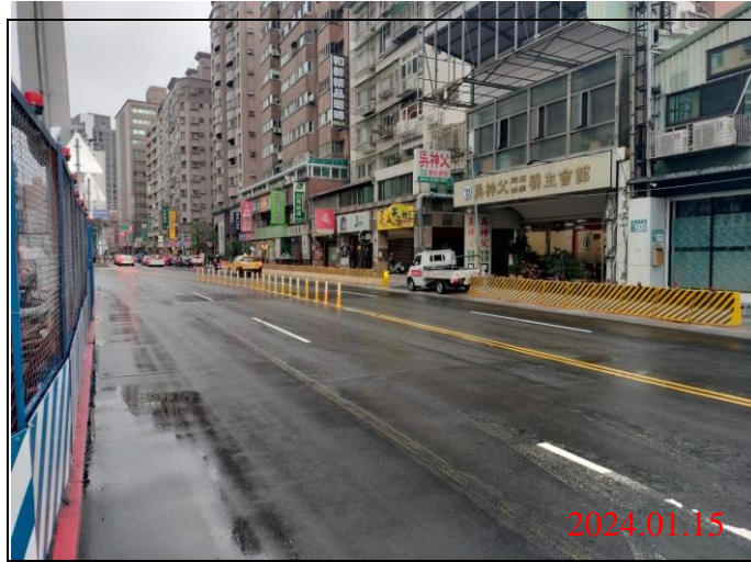
巡查日期地點：113.01.15/ Y22車站 照片說明：路面狀況
