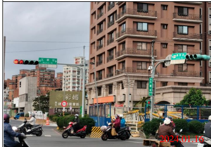
巡查日期地點：113.01.16/ Y22車站 照片說明：牌面設置狀況
