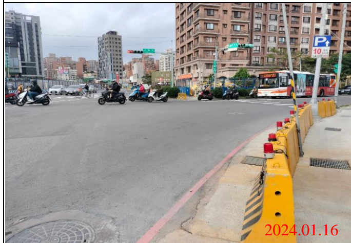
巡查日期地點：113.01.16/ Y22車站 照片說明：路面狀況
