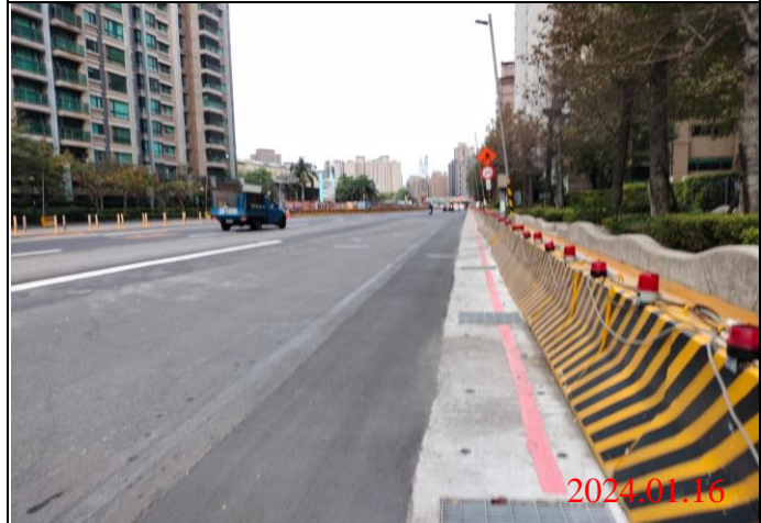
巡查日期地點：113.01.16/ Y23車站 照片說明：路面狀況
