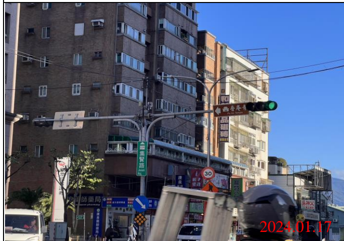
巡查日期地點：113.01.17/ Y22車站 照片說明：牌面設置狀況
