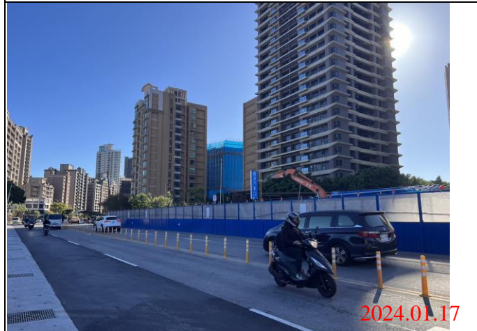
巡查日期地點：113.01.17/ Y22車站 照片說明：路面狀況
