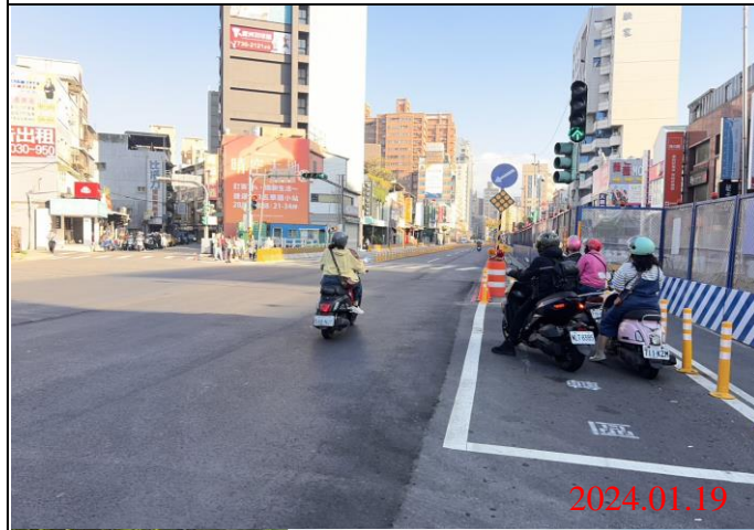
巡查日期地點：113.01.19/ Y21車站 照片說明：路面狀況
