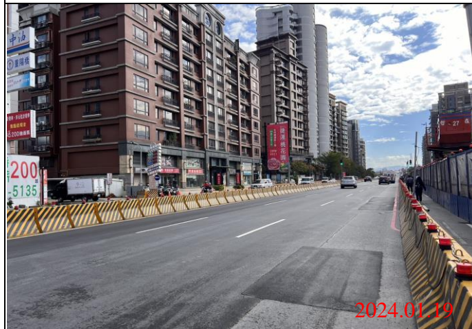
巡查日期地點：113.01.19/ Y23車站 照片說明：路面狀況
