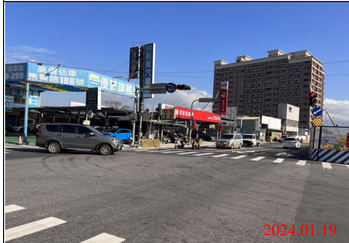
巡查日期地點：113.01.19/ Y22車站 照片說明：路面狀況
