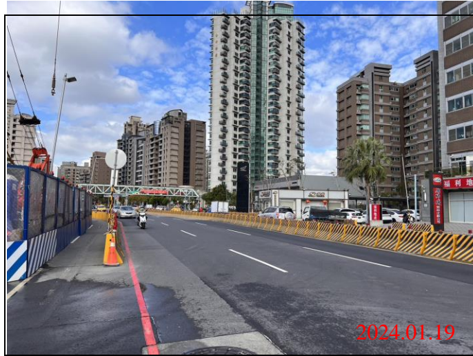
巡查日期地點：113.01.19/ Y23車站 照片說明：路面狀況
