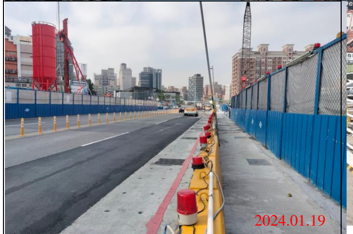
巡查日期地點：113.01.19/ Y22車站 照片說明：路面狀況
