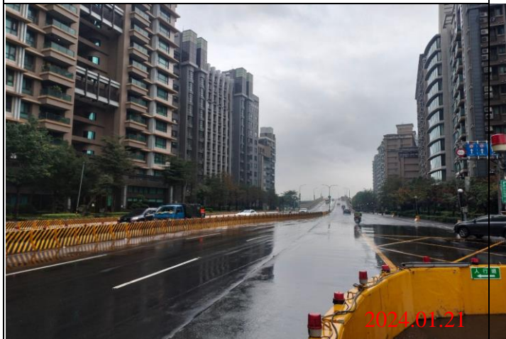
巡查日期地點：113.01.21/ Y23車站 照片說明：路面狀況
