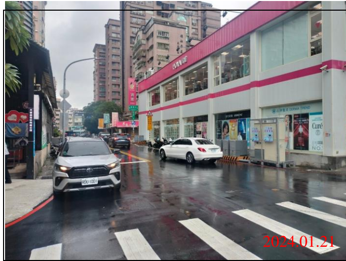
巡查日期地點：113.01.21/ Y21車站 照片說明：路面狀況
