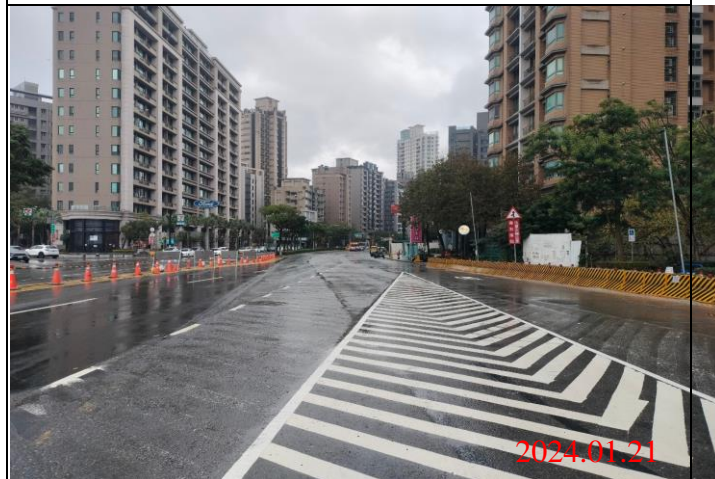
巡查日期地點：113.01.21/ Y22車站 照片說明：路面狀況
