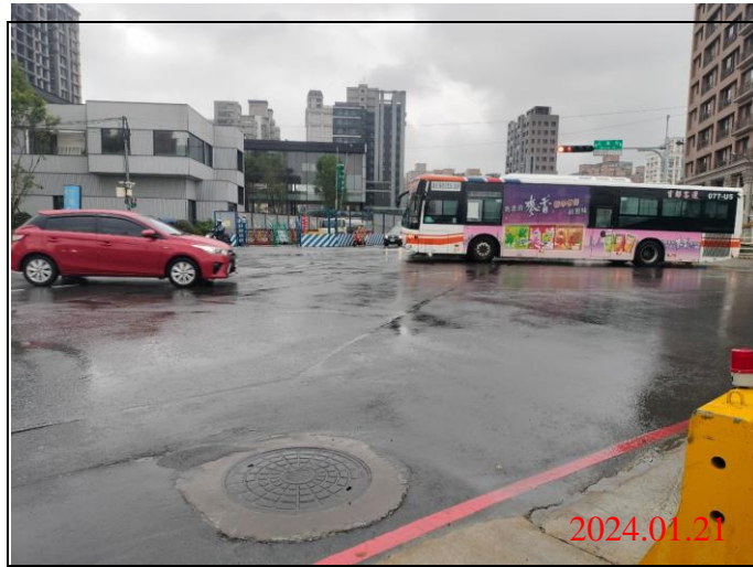
巡查日期地點：113.01.21/ Y22車站 照片說明：路面狀況
