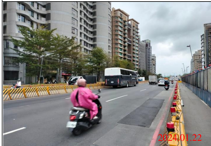
巡查日期地點：113.01.22/ Y23車站 照片說明：路面狀況
