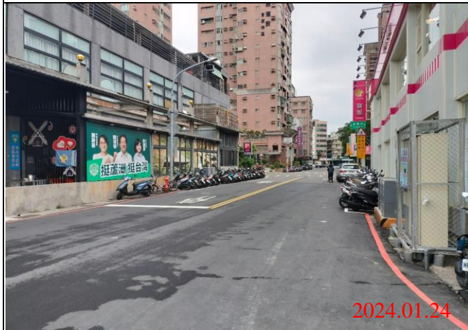
巡查日期地點：113.01.24/ Y21車站 照片說明：路面狀況
