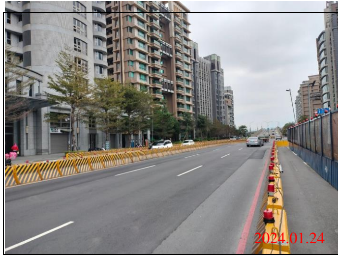
巡查日期地點：113.01.24/ Y23車站 照片說明：路面狀況
