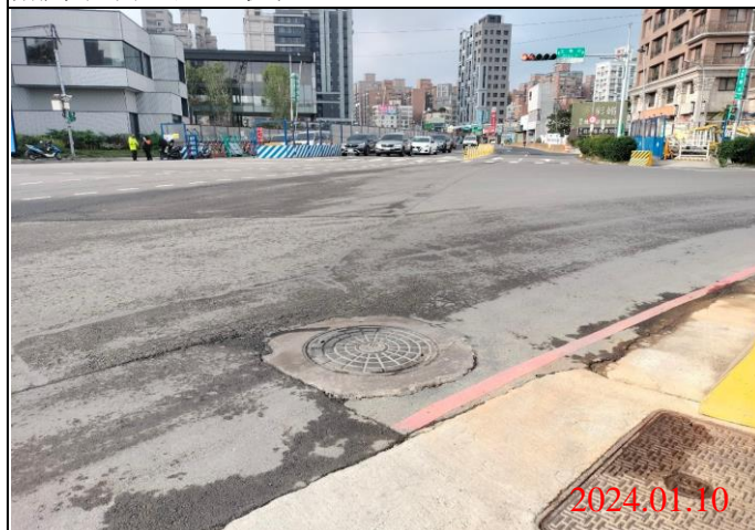
巡查日期地點：113.01.10/ Y22車站 照片說明：路面狀況
