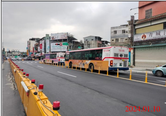
巡查日期地點：113.01.10/ Y21車站 照片說明：路面狀況
