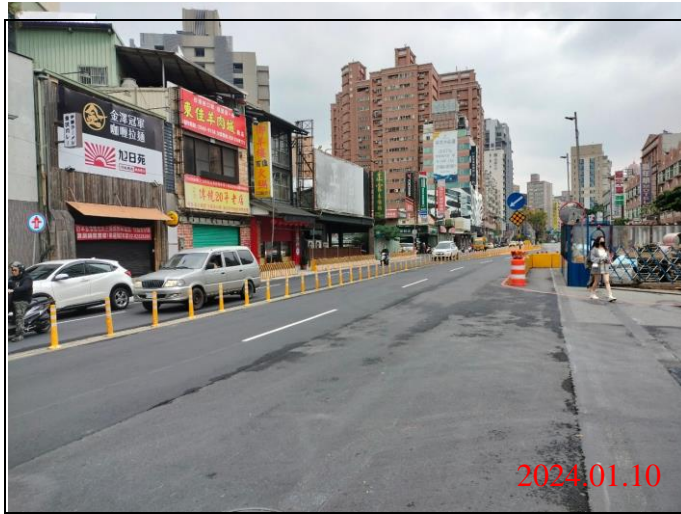
巡查日期地點：113.01.10/ Y21車站 照片說明：路面狀況
