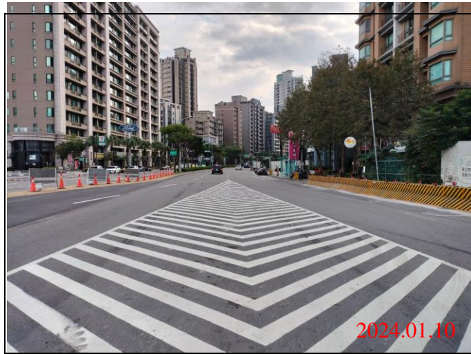
巡查日期地點：113.01.10/ Y22車站 照片說明：路面狀況
