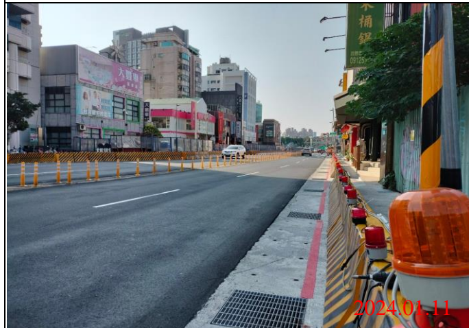
巡查日期地點：113.01.11/ Y21車站 照片說明：路面狀況
