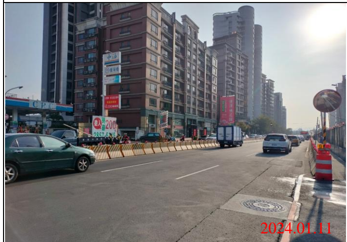
巡查日期地點：113.01.11/ Y23車站 照片說明：路面狀況
