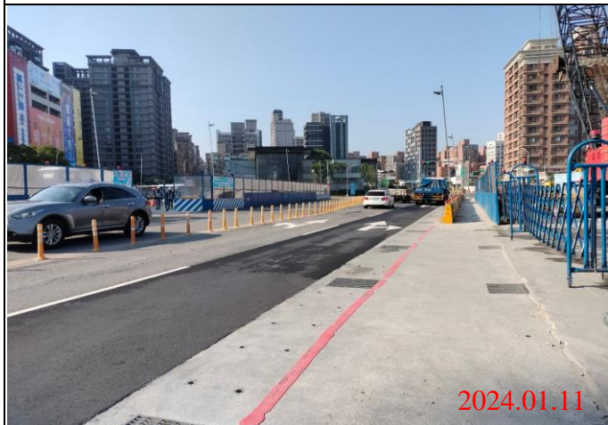
巡查日期地點：113.01.11/ Y22車站 照片說明：路面狀況
