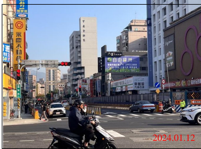
巡查日期地點：113.01.12/ Y21車站 照片說明：路面狀況
