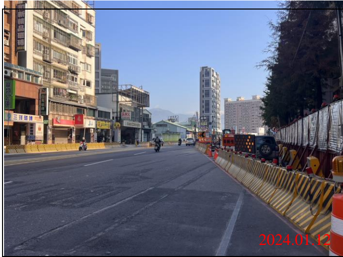
巡查日期地點：113.01.12/ Y22車站 照片說明：路面狀況
