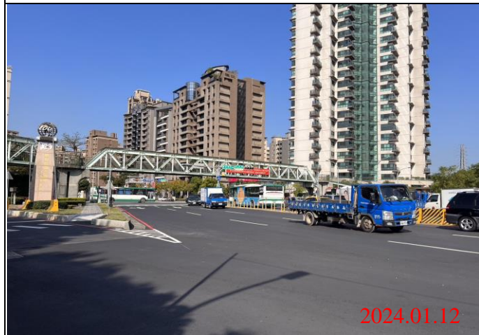
巡查日期地點：113.01.12/ Y23車站 照片說明：路面狀況
