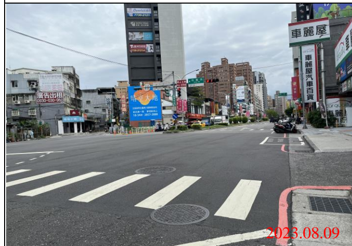
巡查日期地點：112.08.09/ Y21車站 照片說明：路面狀況
