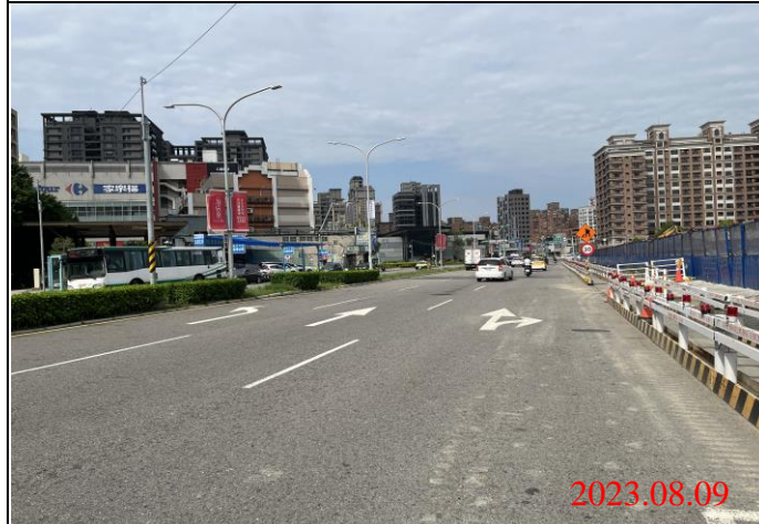
巡查日期地點：112.08.09/ Y22車站 照片說明：路面狀況
