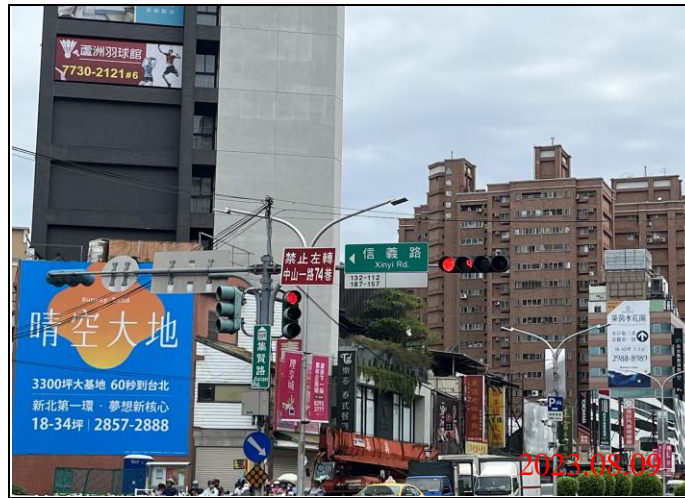
巡查日期地點：112.08.09/ Y21車站 照片說明：牌面設置狀況
