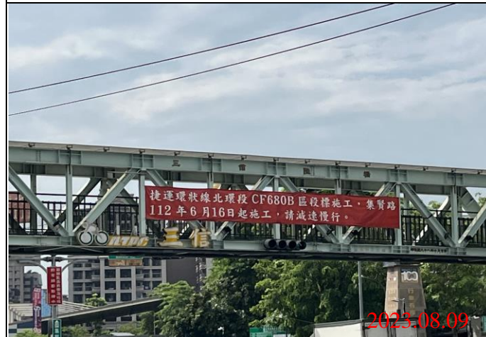
巡查日期地點：112.08.09/ Y23車站 照片說明：牌面設置狀況
