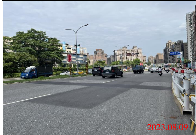
巡查日期地點：112.08.09/ Y23車站 照片說明：路面狀況
