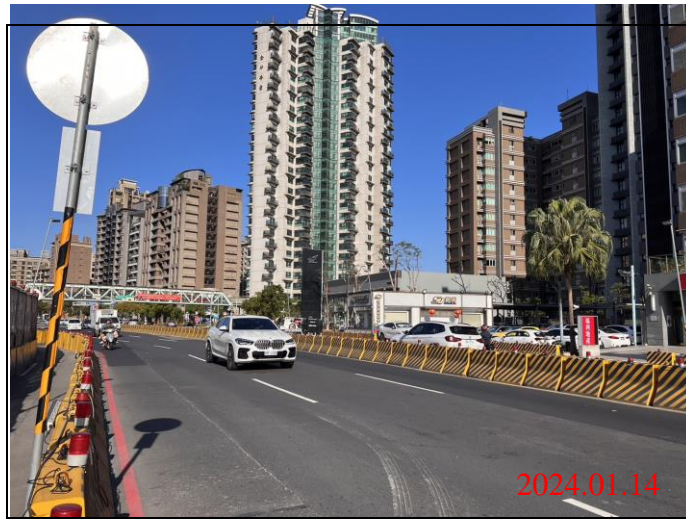
巡查日期地點：113.01.14/ Y23車站 照片說明：路面狀況
