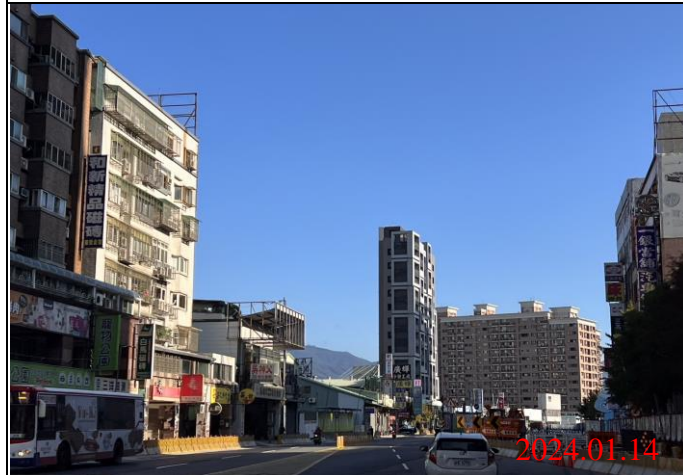
巡查日期地點：113.01.14/ Y22車站 照片說明：路面狀況
