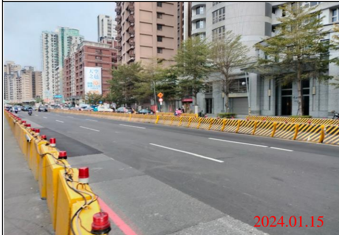
巡查日期地點：113.01.15/ Y23車站 照片說明：路面狀況
