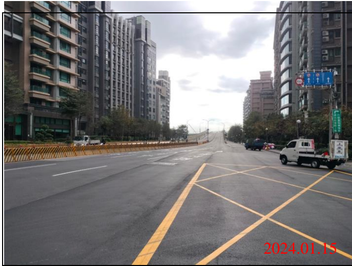
巡查日期地點：113.01.15/ Y23車站 照片說明：路面狀況
