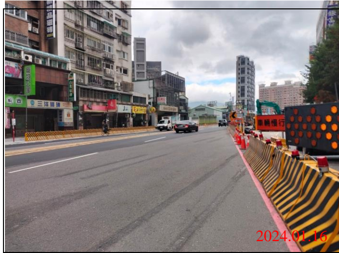
巡查日期地點：113.01.16/ Y22車站 照片說明：路面狀況
