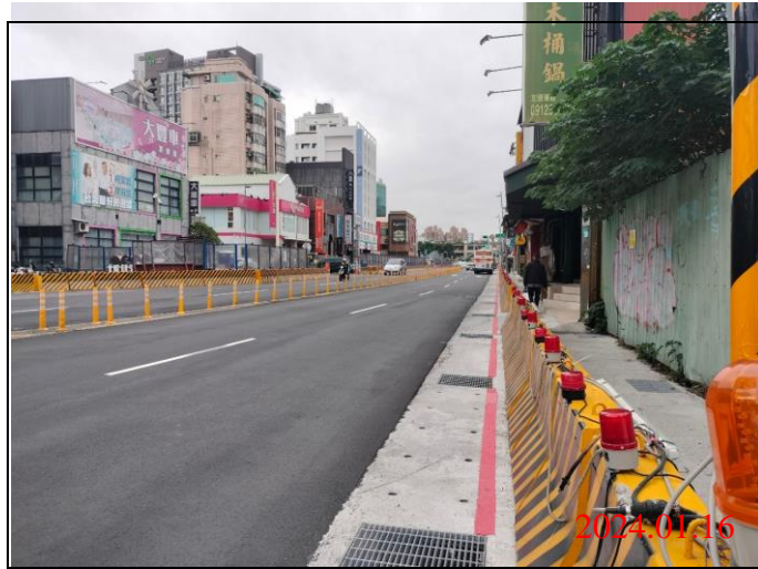
巡查日期地點：113.01.16/ Y21車站 照片說明：路面狀況
