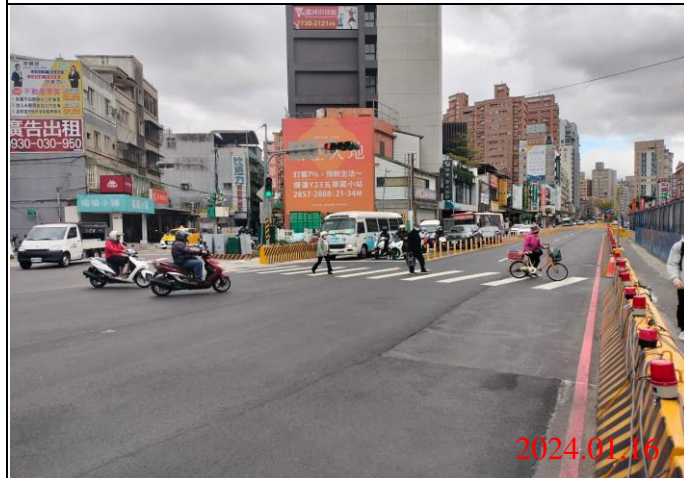
巡查日期地點：113.01.16/ Y21車站 照片說明：路面狀況
