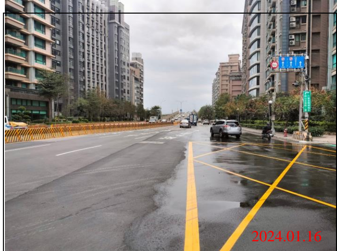
巡查日期地點：113.01.16/ Y23車站 照片說明：路面狀況
