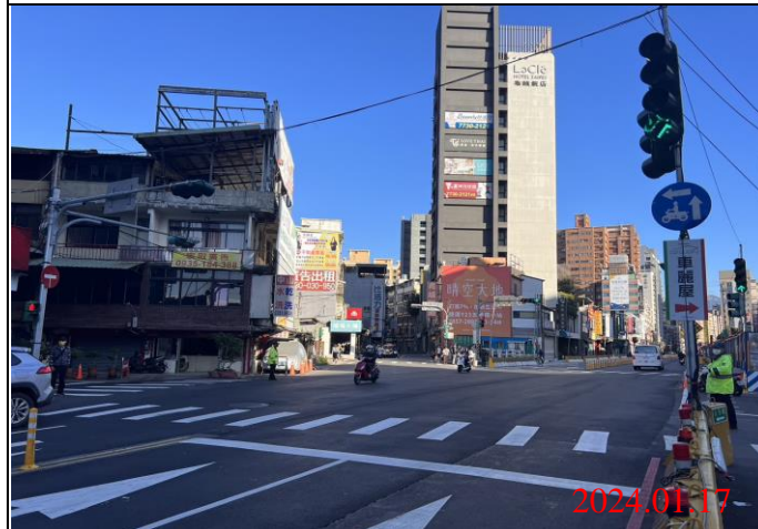
巡查日期地點：113.01.17/ Y21車站 照片說明：路面狀況
