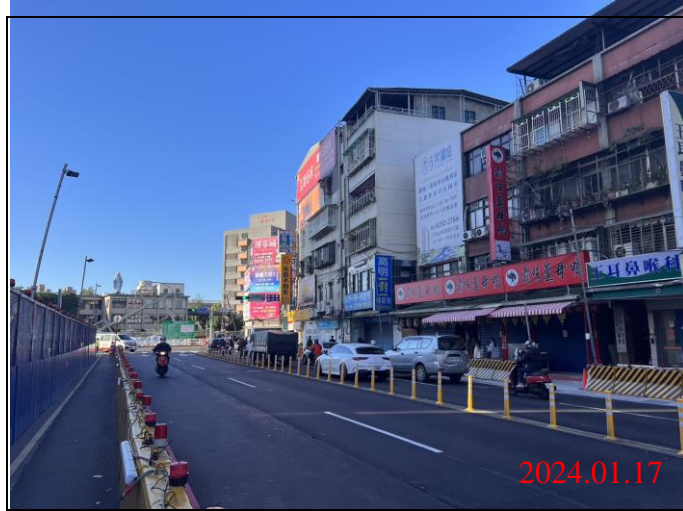
巡查日期地點：113.01.17/ Y21車站 照片說明：路面狀況
