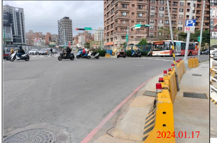
巡查日期地點：113.01.17/ Y22車站 照片說明：路面狀況
