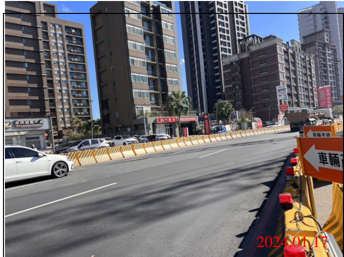
巡查日期地點：113.01.17/ Y23車站 照片說明：路面狀況
