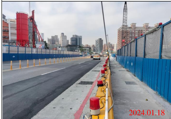
巡查日期地點：113.01.18/ Y22車站 照片說明：路面狀況
