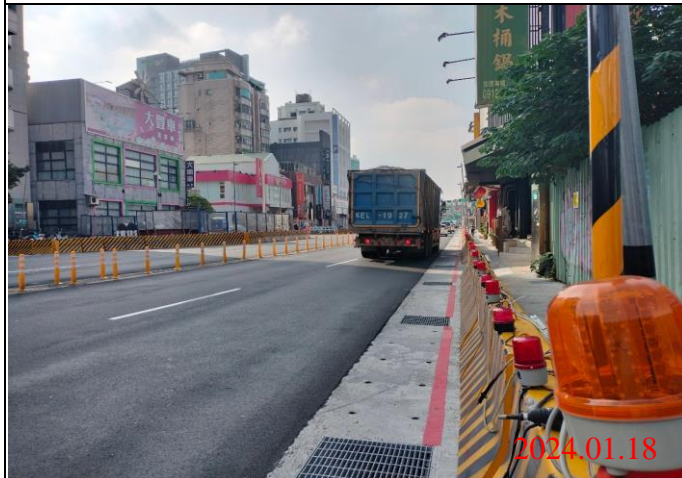
巡查日期地點：113.01.18/ Y21車站 照片說明：路面狀況
