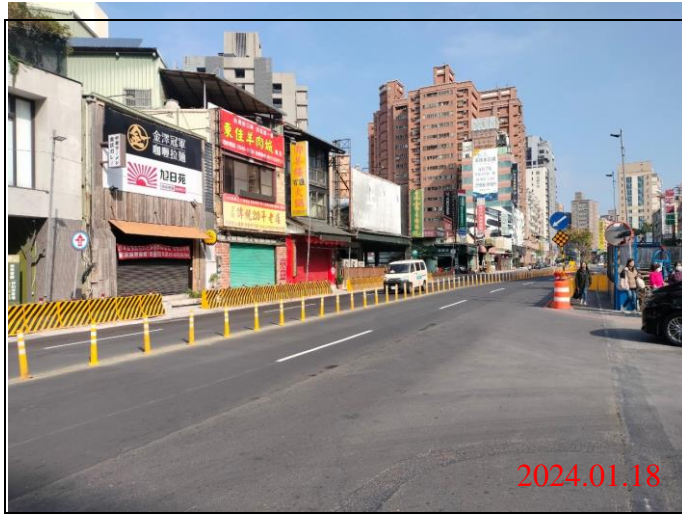
巡查日期地點：113.01.18/ Y21車站 照片說明：路面狀況
