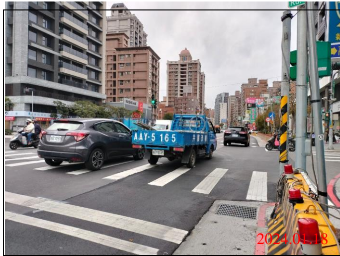
巡查日期地點：113.01.18/ Y22車站 照片說明：路面狀況
