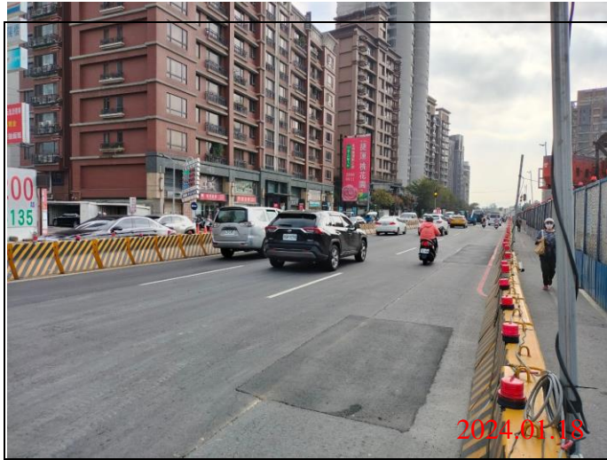
巡查日期地點：113.01.18/ Y23車站 照片說明：路面狀況
