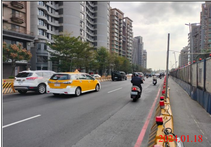
巡查日期地點：113.01.18/ Y23車站 照片說明：路面狀況
