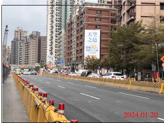
巡查日期地點：113.01.20/ Y23車站 照片說明：路面狀況
