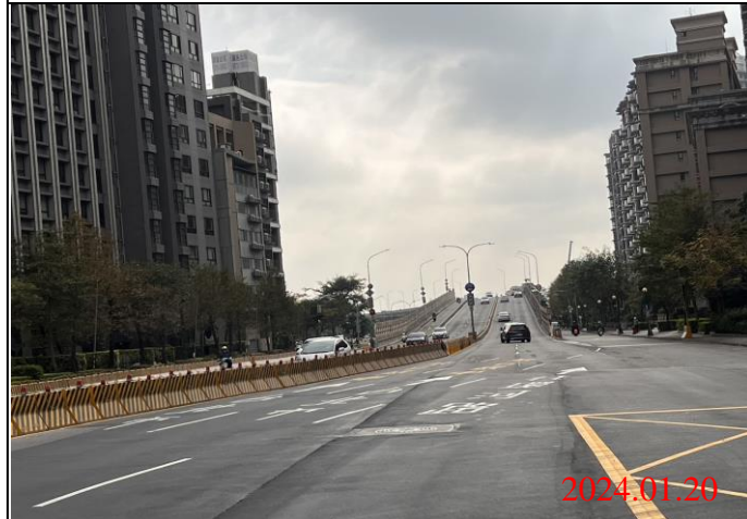
巡查日期地點：113.01.20/ Y23車站 照片說明：路面狀況
