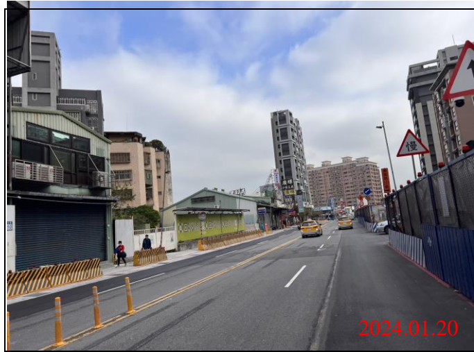
巡查日期地點：113.01.20/ Y22車站 照片說明：路面狀況
